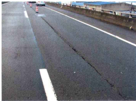
铰缝失效单板受力导致的桥面纵向裂缝
