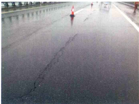
铰缝失效单板受力导致的桥面纵向裂缝
