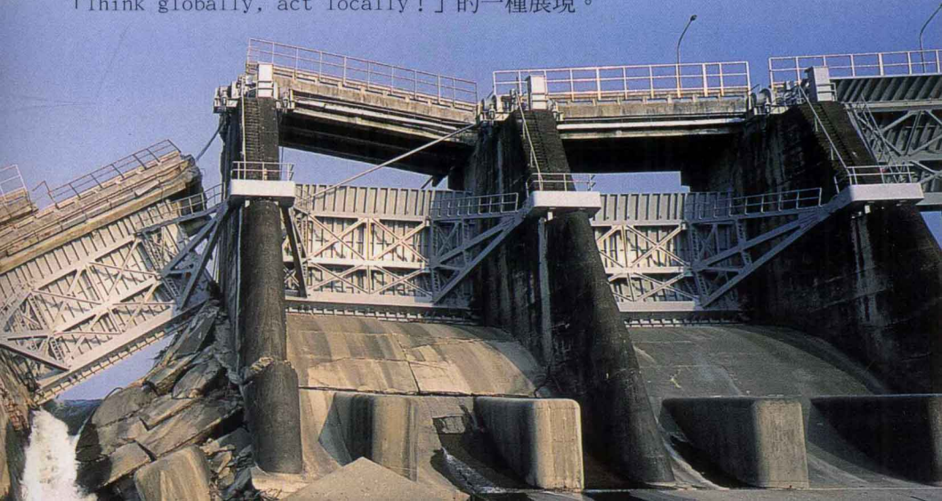
▼經九二一地震擠壓斷落的石岡壩，落差將近九公尺。
