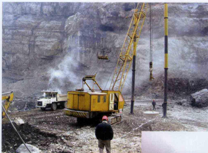
大坝基础强夯处理
