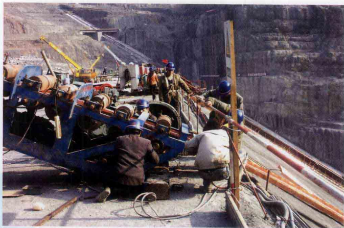
长止水铜片制作与安装
