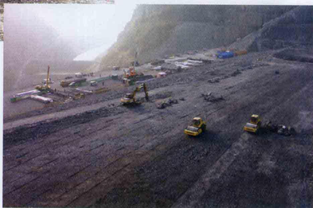
大坝反抬填筑法施工
