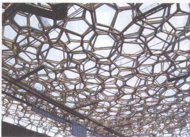
图 7-54 多面体空间刚架屋盖钢结构
