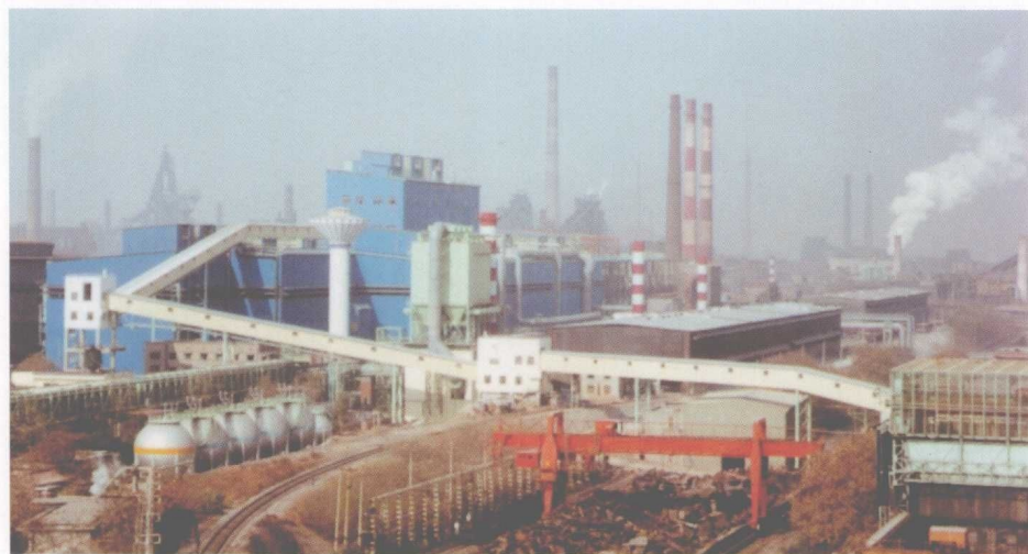
竣工后的“平改转”工程外景
