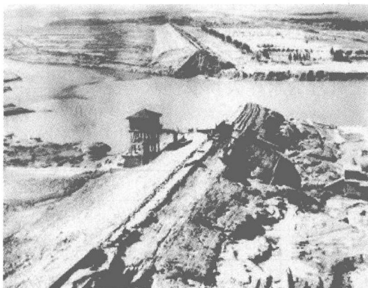
图 1.1 河南板桥水库溃口（1975）
