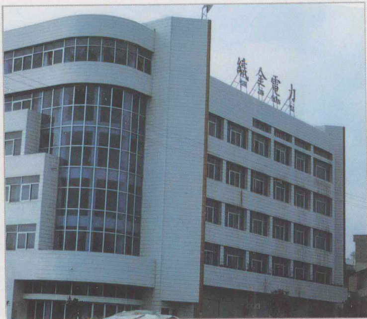
县电力局大楼
