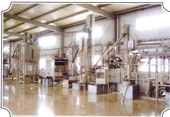
四川省峨眉山竹叶青茶业有限公司精制车间
