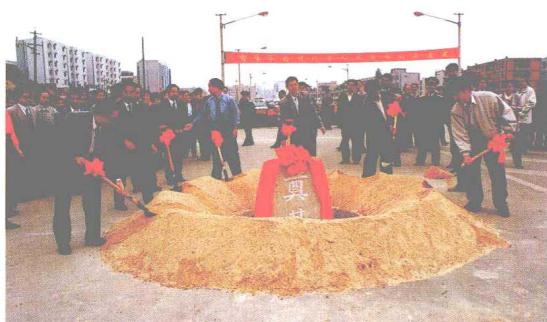
1996年9月29日，南城門暨人民廣場开工儀式
