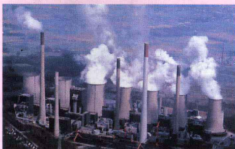
德国鲁尔区综合整治后的发电厂
