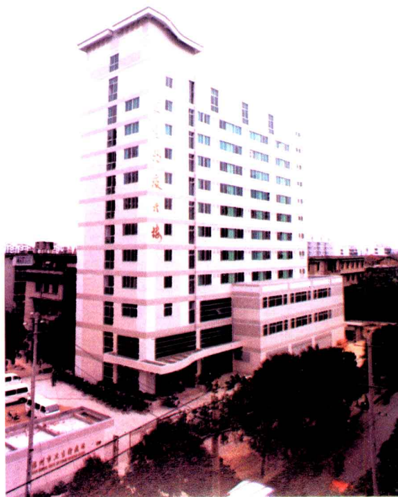
福州市卫生防疫站防疫大楼
