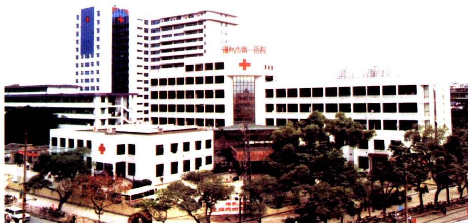
福州市第一医院 (福州红十字会医院) 元洪门诊楼和15层 病房大楼
