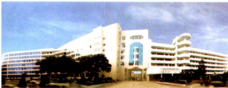
福建省福清卫生学校教学综合楼
