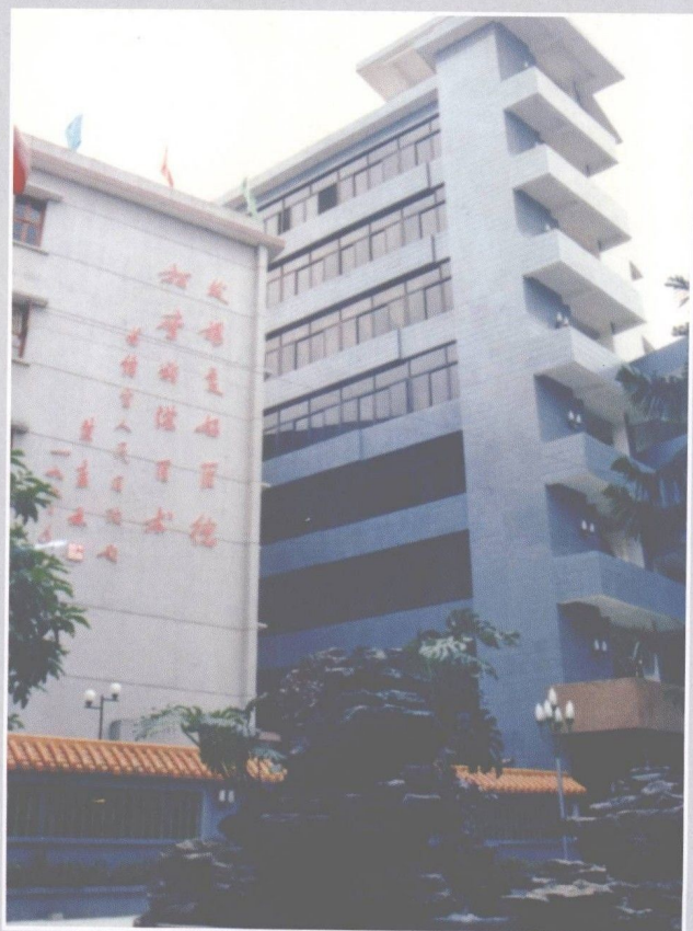
人民医院综合大楼一角
