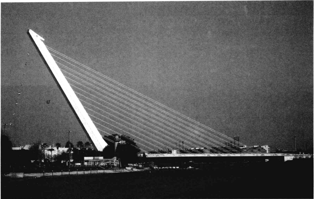
图1.2 阿拉米罗大桥竖琴般的侧景
