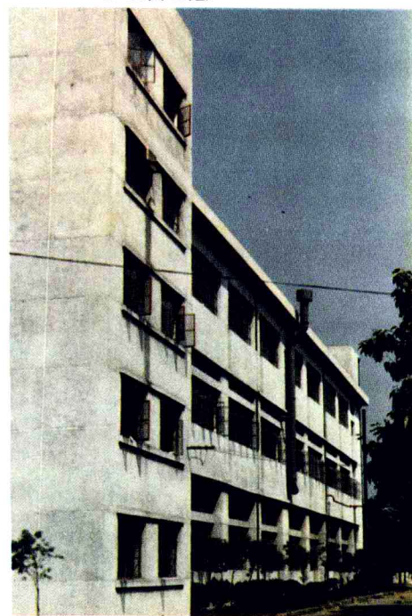
○ 南昌电池厂引进线车间
