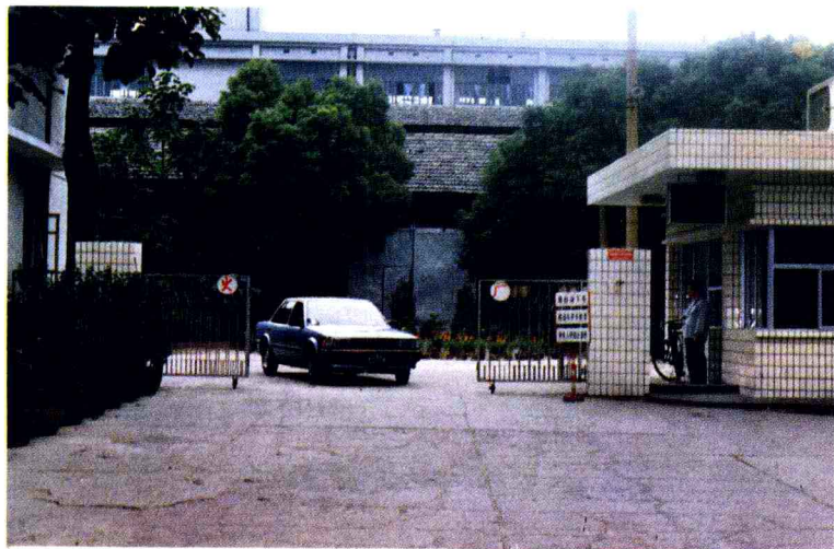
○ 江西印刷公司生产区
