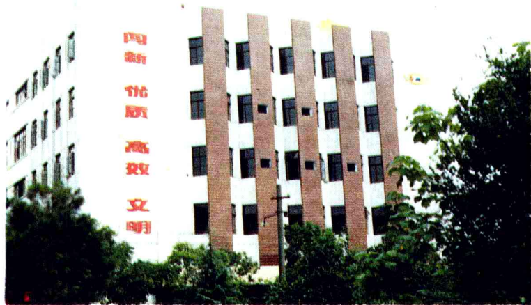
○ 江西油脂化工厂香皂大楼
