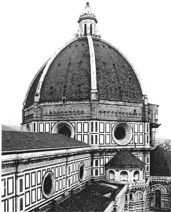
● 图 1-10 佛罗伦萨大教堂的直径 42m 的“巨大”穹顶在当时绝对惊世骇俗
