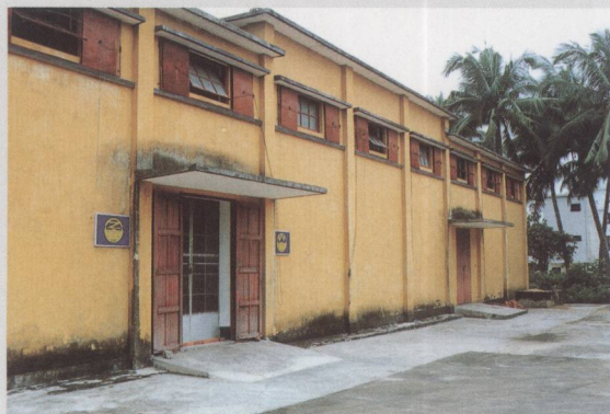
20世纪60年代 建造的钢筋混凝土 土房土仓
