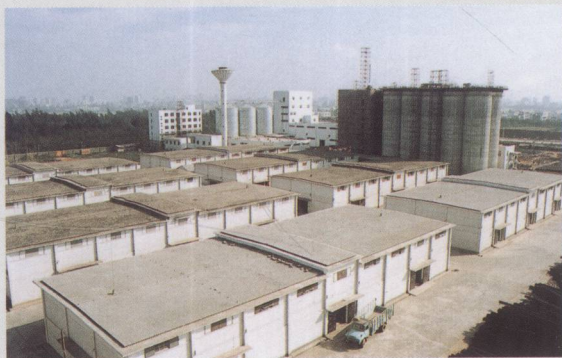
20世纪80年代 建造的框架式钢 筋混凝土平顶包 堆粮仓群
