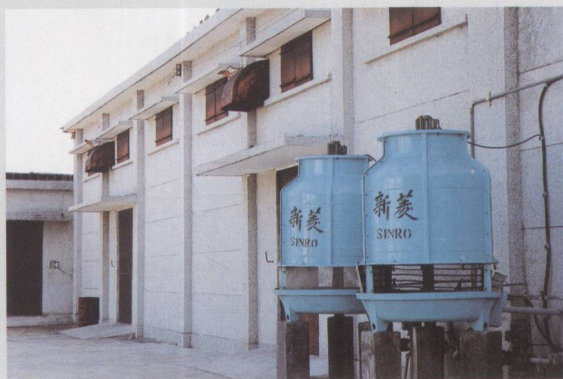
配备空调设施 的西沙粮所库区
