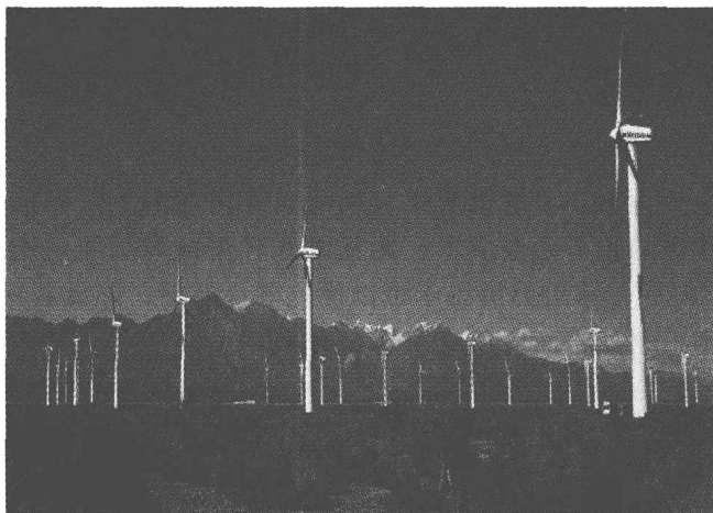
图 1-3 三叶片上风向水平轴风力机
