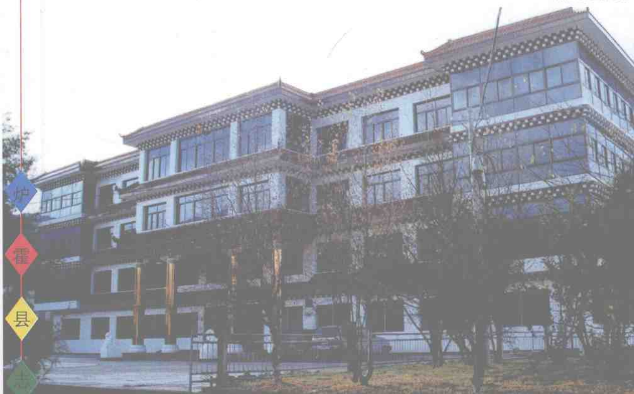
政府办公大楼
