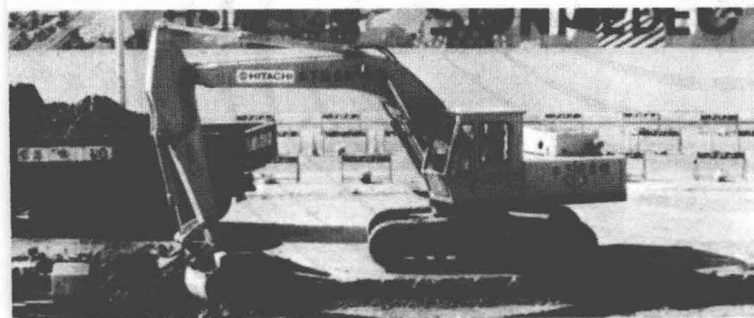
▲ 挖土机等建筑机械最适合于“力气活”
