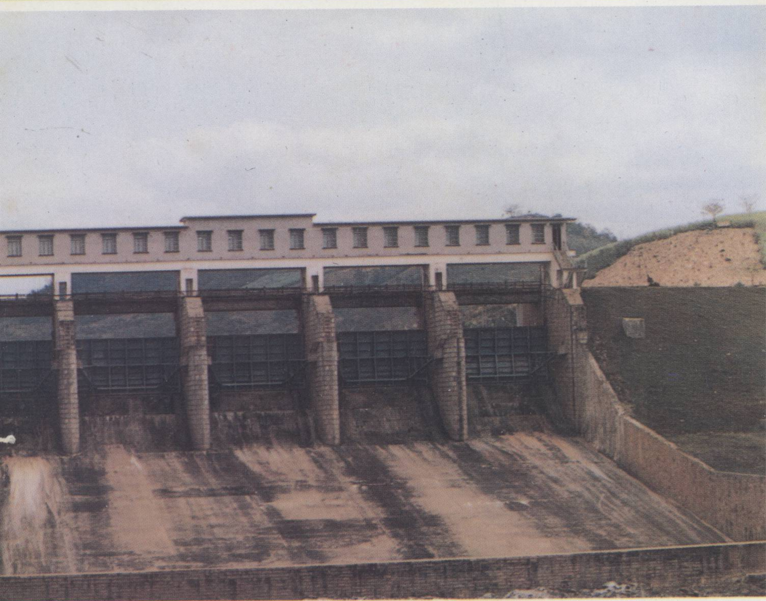
▼石碌水库溢洪道
