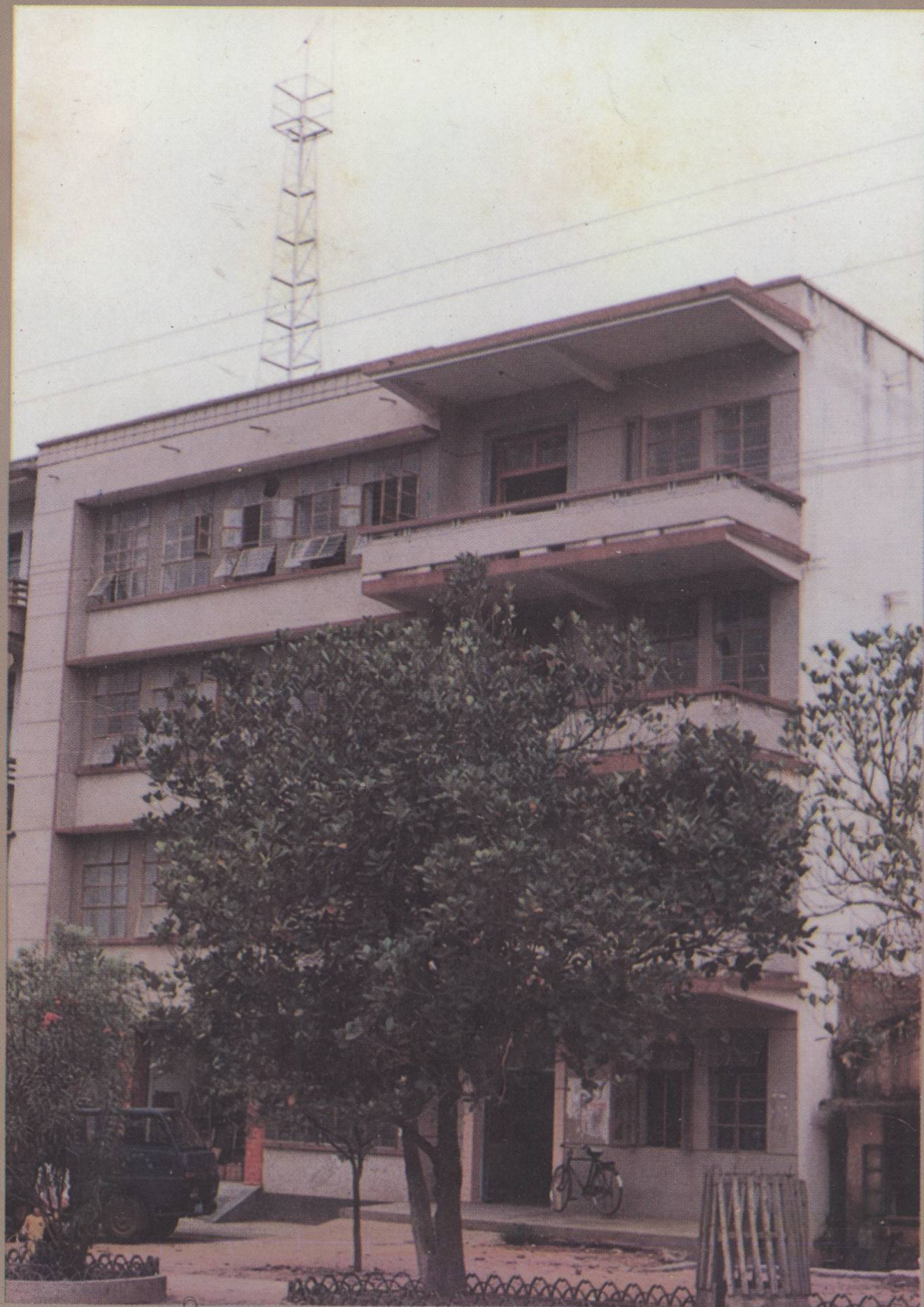
昌江县水电大楼正面图
