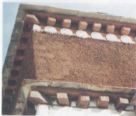
土、木、石相间的高位稳构方式
