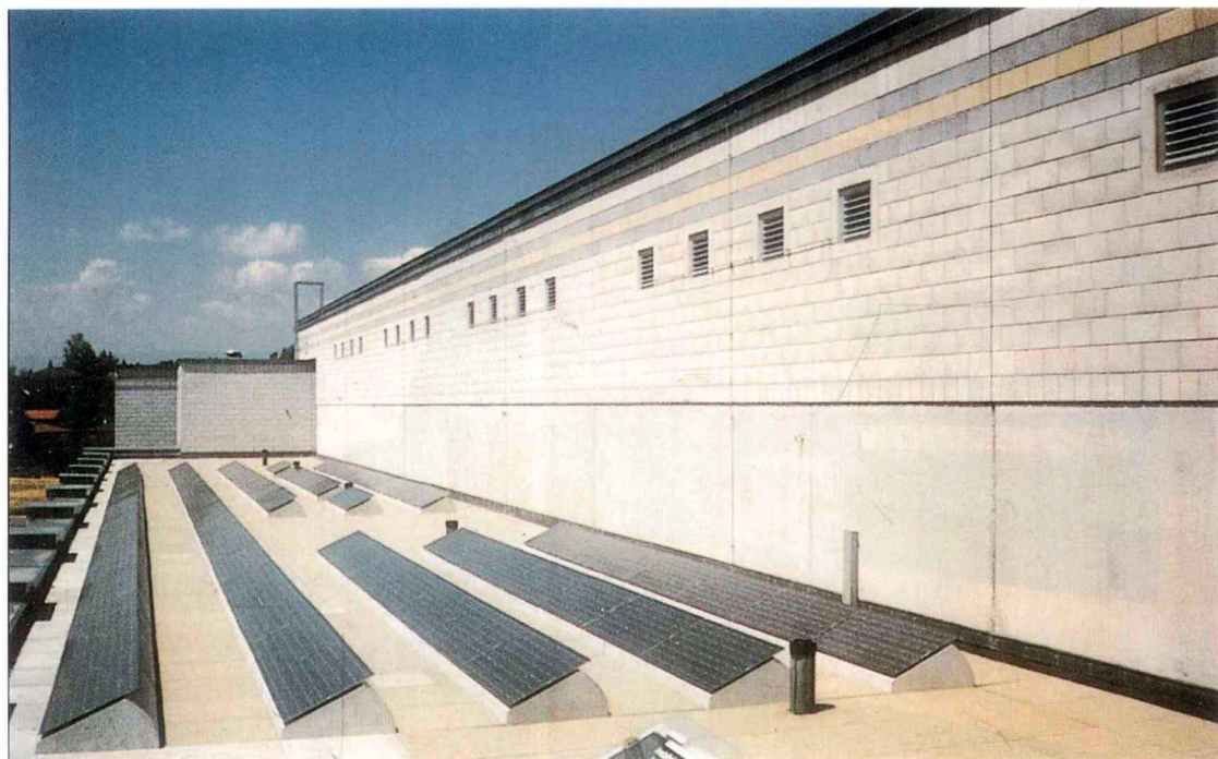
彩色圖片 16 SOFREL，太陽電池平屋頂構材 全景
