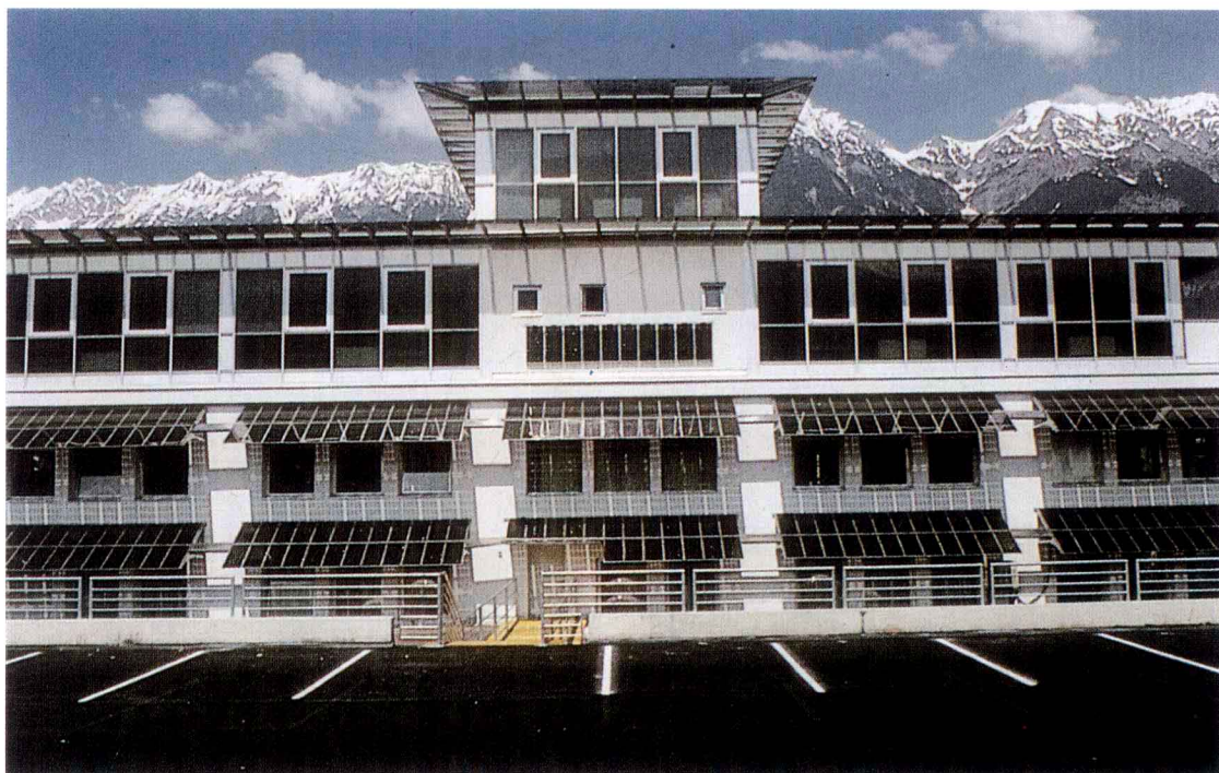
彩色圖片 1 Handelshaus A. Wild, Innsbruck, 奧地利 13kWp 光伏電池牆面 (IEA Task 16 展示建築物)
