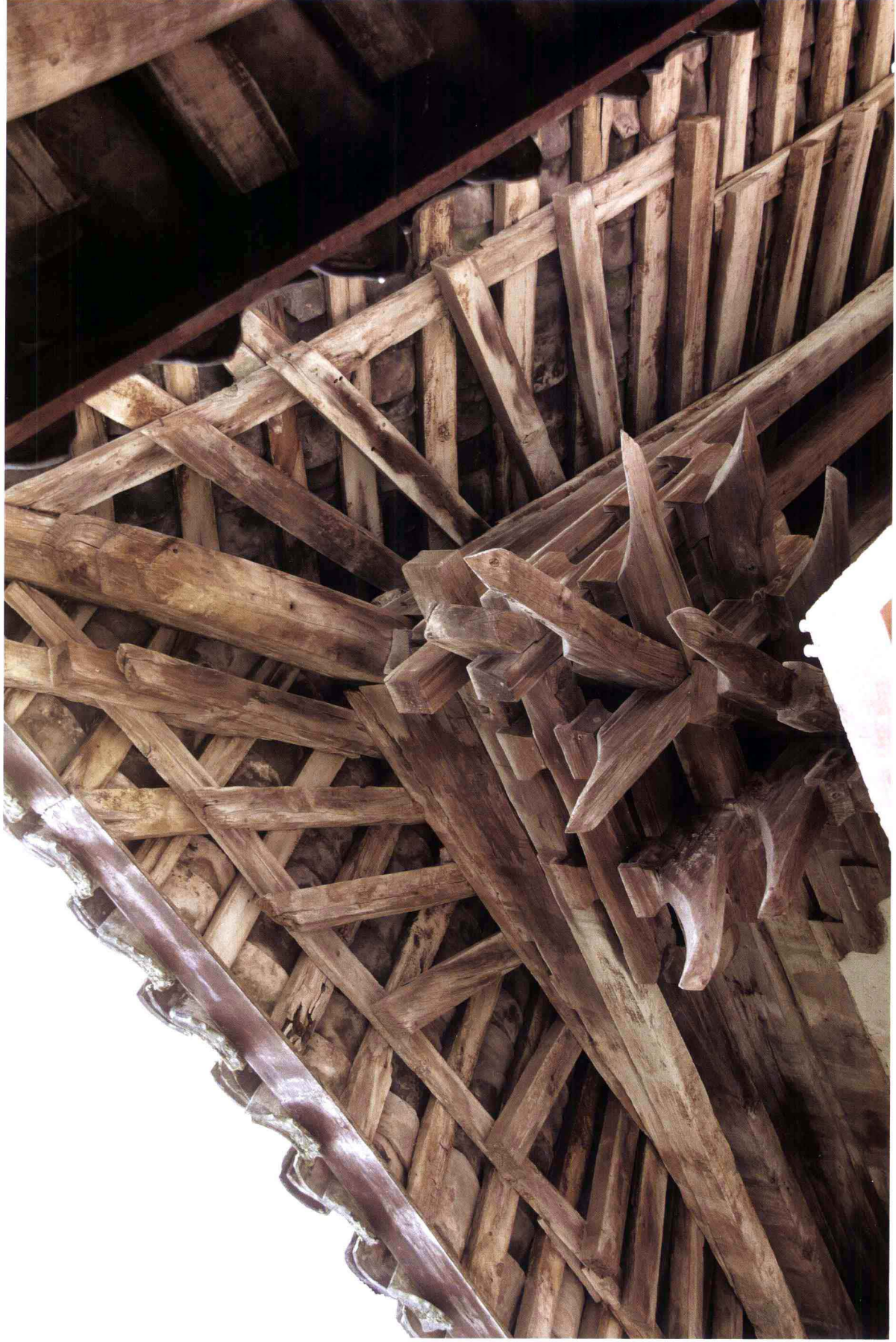
蓬溪宝梵寺大雄殿转角铺作
