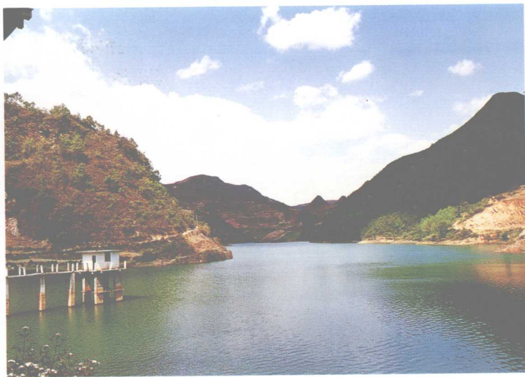
大坪石桥水库
