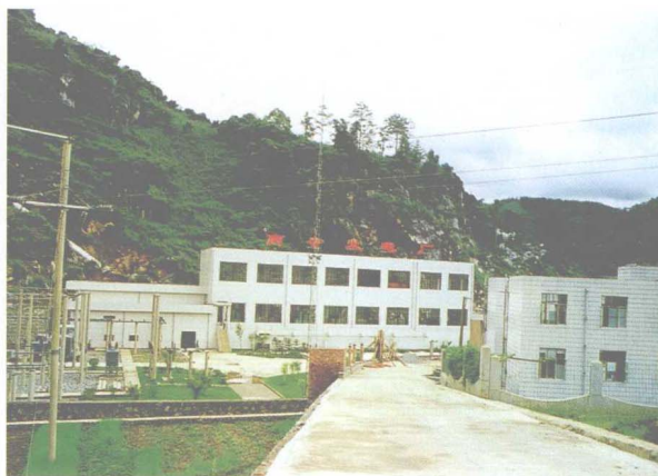
新建的南令电站
