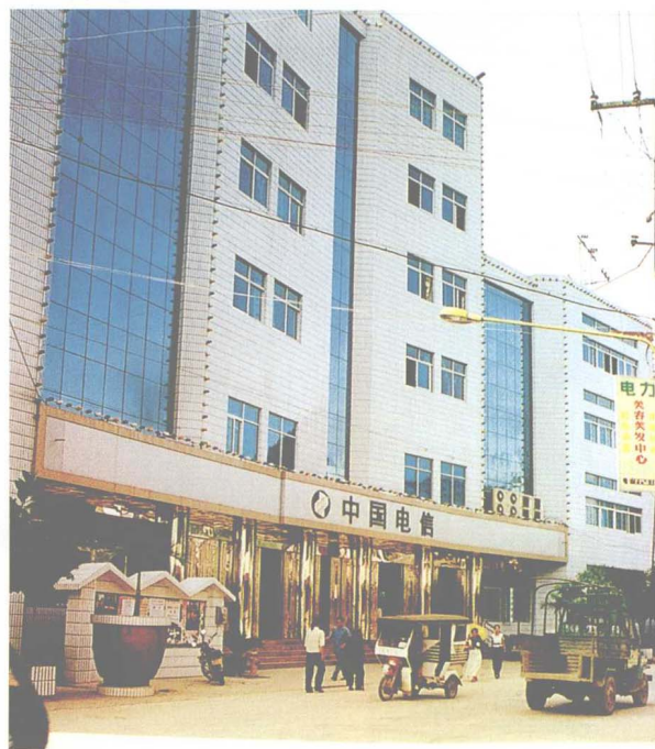
新建的电信大楼
