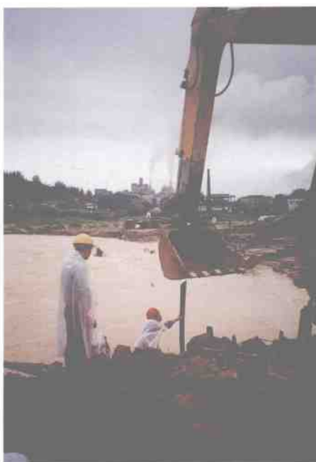
利用机械打桩护堤。
