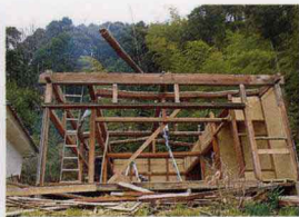
解体工事，运送主体和门窗。*
