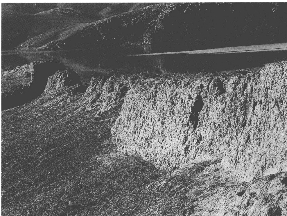
2. 乌拉特前旗小余太乡增隆昌古城西墙土筑墙体
