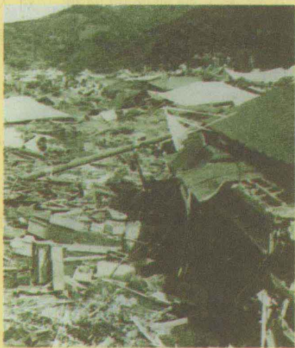
图 1-5 1923 年日本关东大地震中倒塌的房屋
