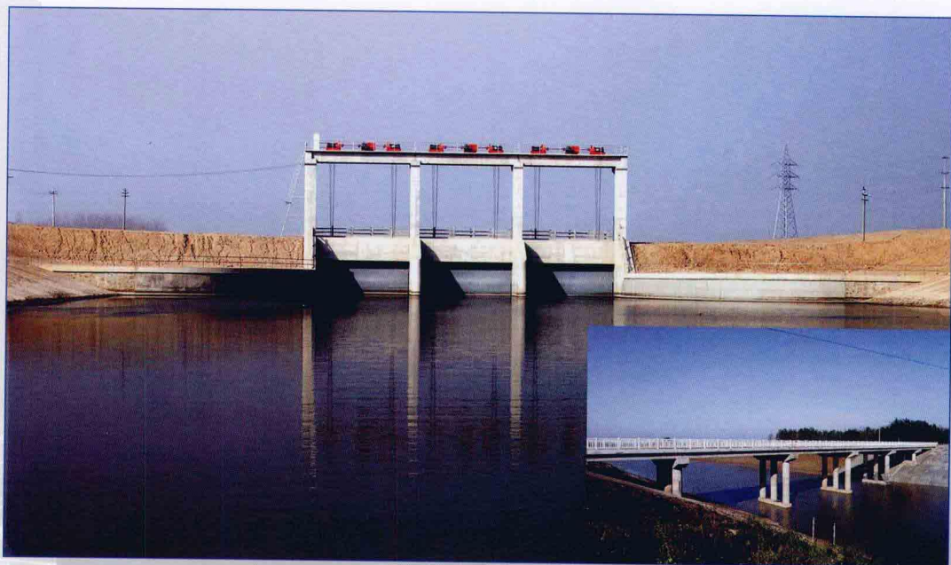
■ 2005年10月，放水后的刘山泵站导流闸和跨导流河公路桥。
