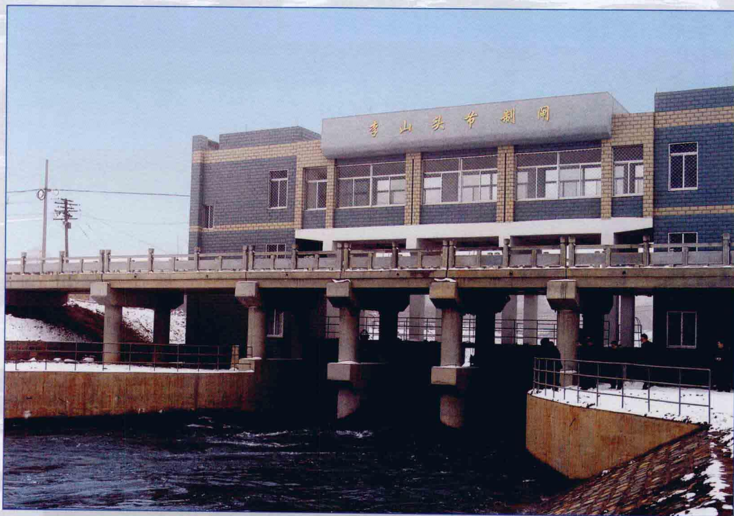
■ 2005年12月，南水北调东线一期工程济平干渠通水试验。
