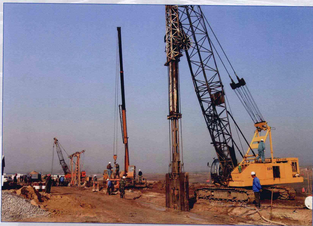
■ 2005年11月，南水北调东线一期工程刘山泵站主体工程南侧混凝土连续墙施工现场。
