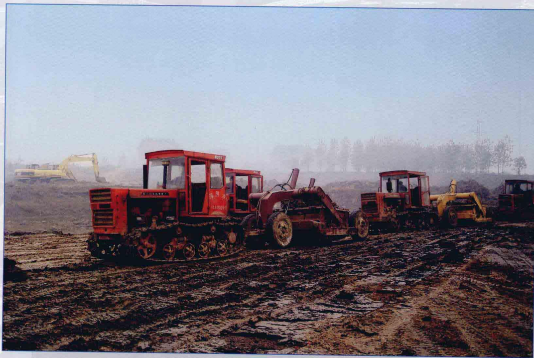
■ 2005年10月，南水北调东线一期工程淮阴三站引河工程施工现场。
