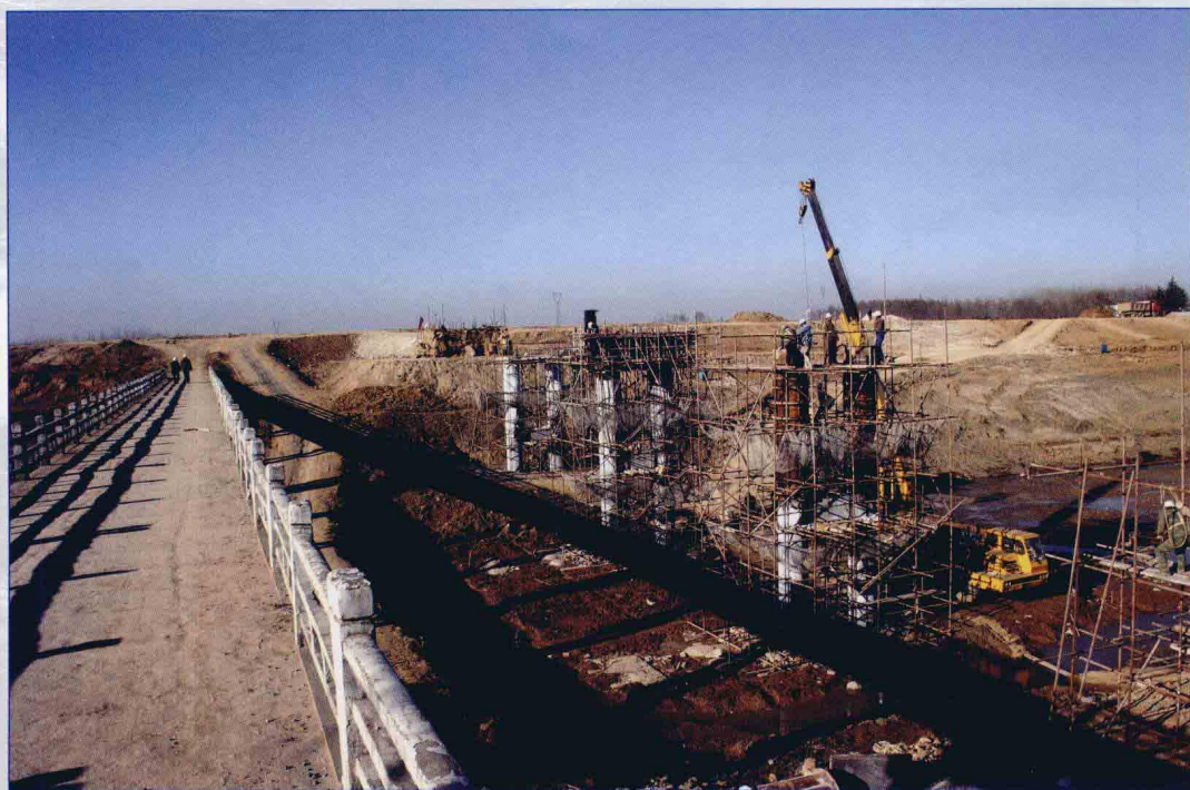
■ 2005年12月，南水北调东线一期工程淮安四站施工现场。
