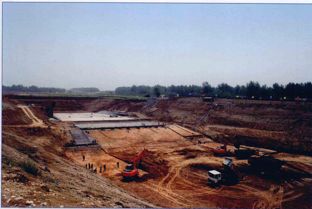
■ 2005年8月，南水北调东线一期工程万年闸泵站基础施工现场。
