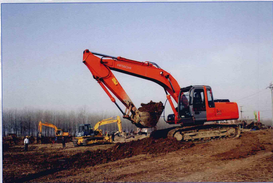
■ 2005年11月，南水北调东线一期工程蔺家坝泵站工程开工建设。
