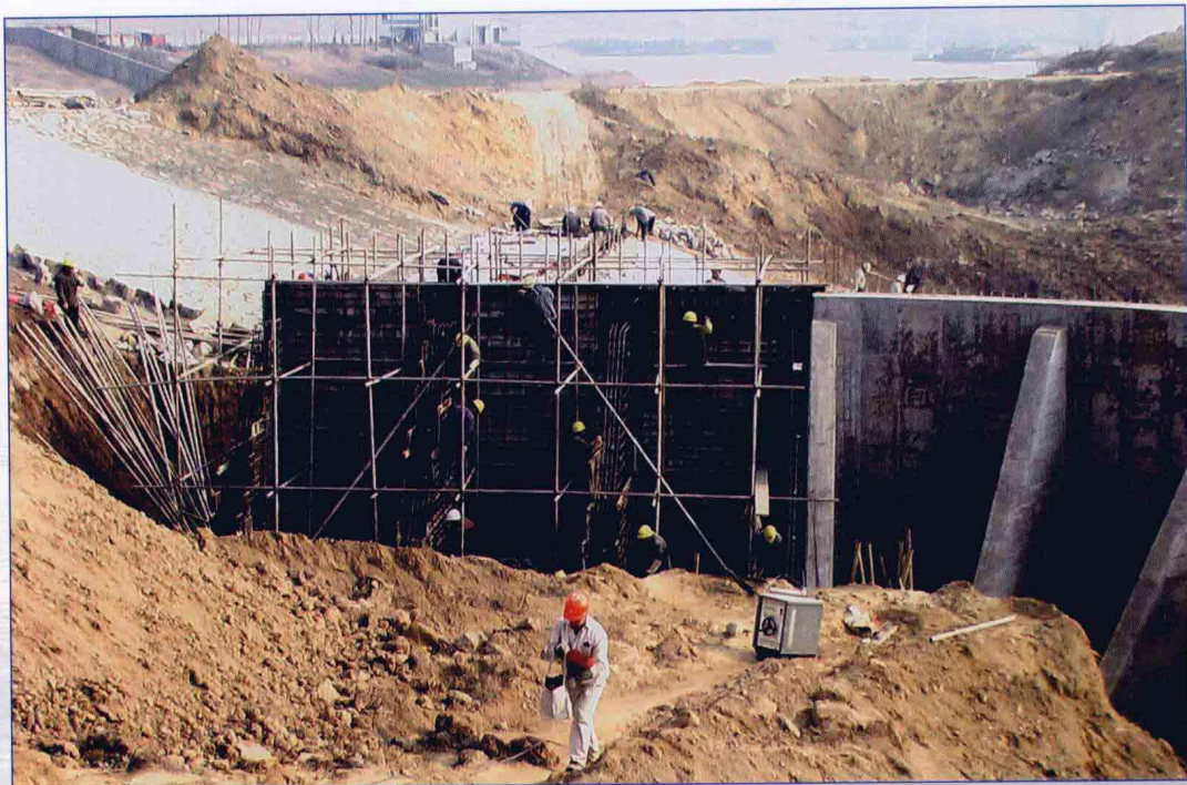
■ 2005年1月，南水北调东线一期工程解台泵站导流闸公路桥扎钢筋施工现场。
