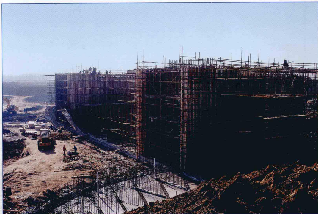
■ 2005年10月，南水北调东线一期工程淮阴三站高良涧越闸改建（挡洪闸）工程施工现场。
