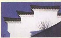
**封火墙** 又称马头墙，指山墙的墙顶部分，有防火作用。构造为层层迭落，上覆以小青瓦，并在垛头顶端安装各种座头。
