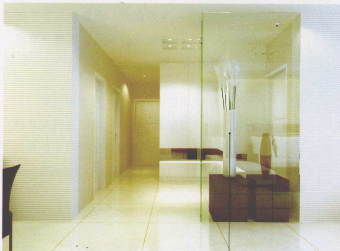
钢化玻璃隔墙
