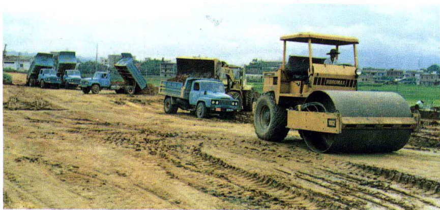
▲ 国道 205 线渡江津段施工场面
