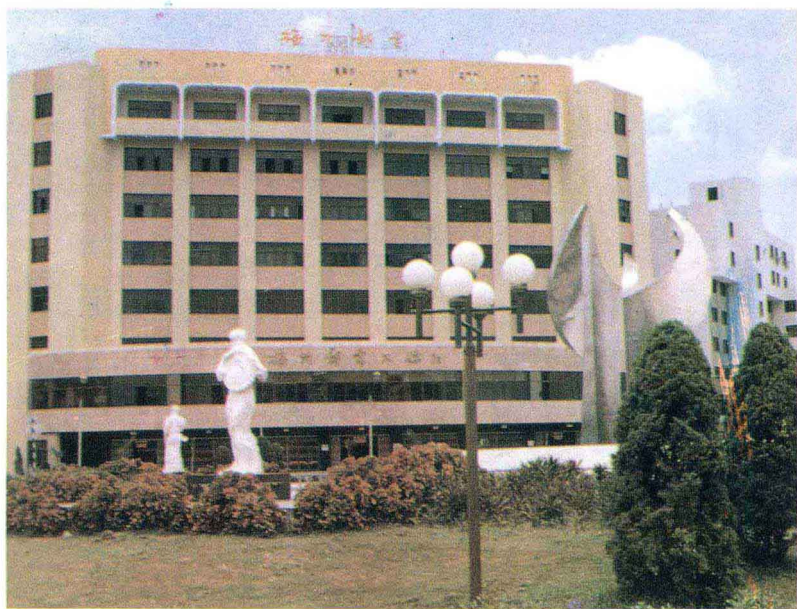
◀ 杭州邮电大楼外景
