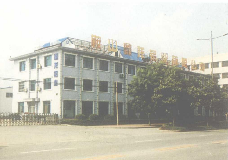
鞍山鑫龙铝业有限公司办公楼
