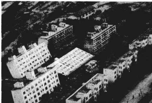
图 1.9 日本新潟砂土液化导致地基丧失承载力
