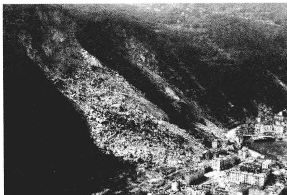
图 1.8 汶川县城山体滑坡塌方
