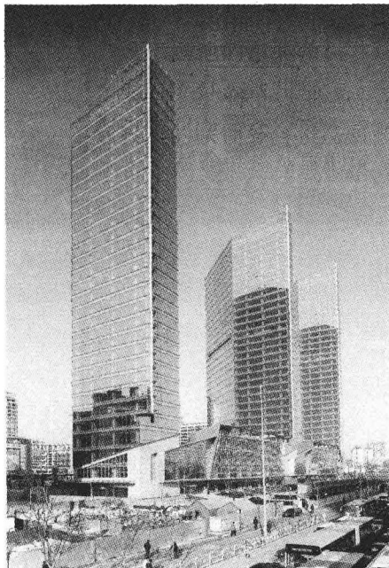
北京华贸中心（一期工程）办公楼 沿长安街全景
