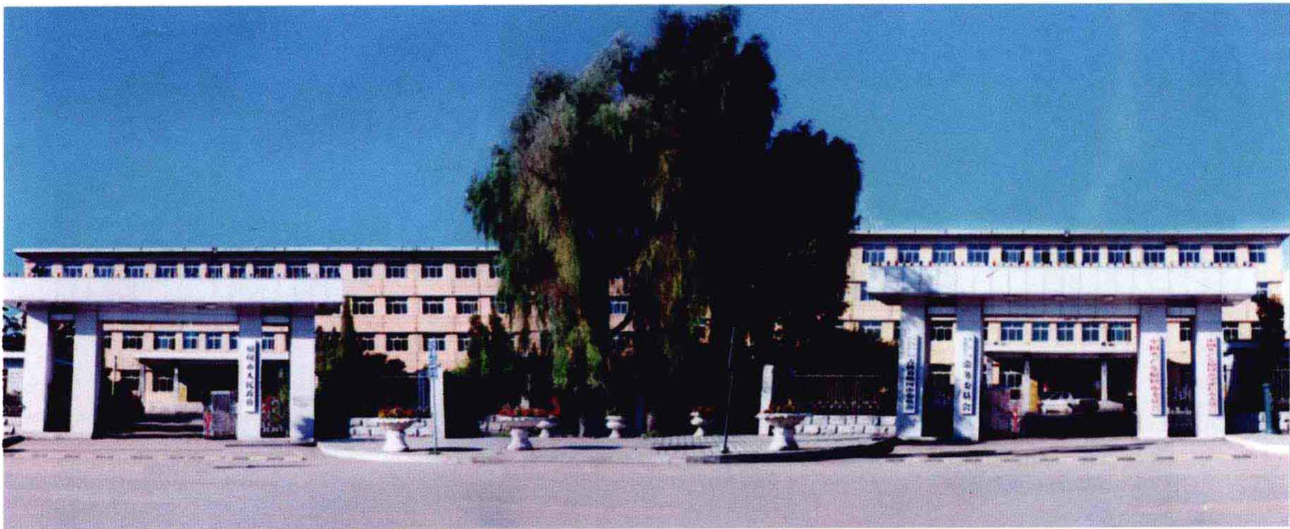
榆树市委、市人大、市政府、市政协办公楼
