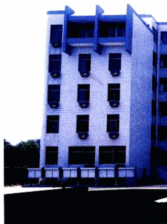
▲新落成的教学大楼。
