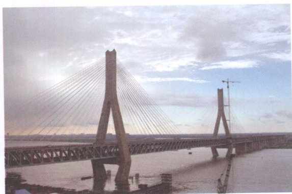
① 武汉天兴洲大桥
