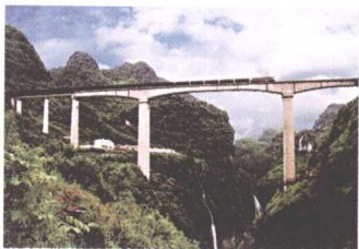
① 跨谷桥——南昆铁路清水河桥
