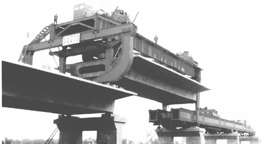
秦沈客运专线箱梁架设
