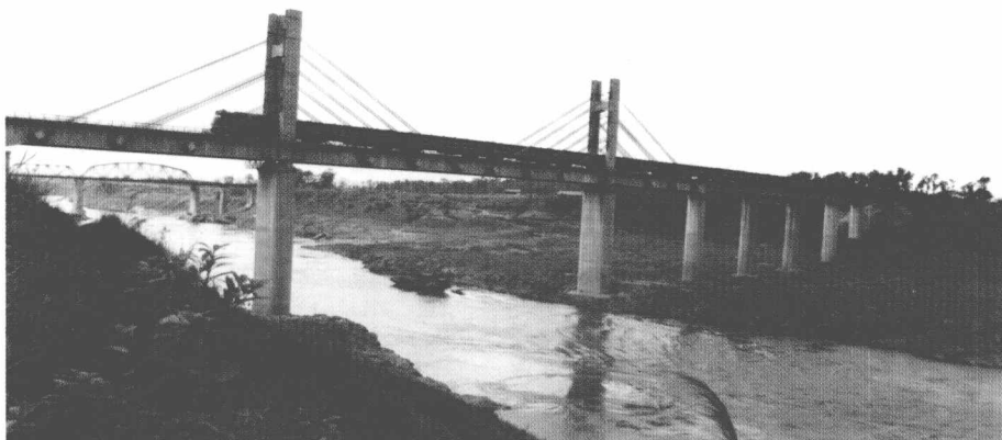
湘桂铁路二线红水河斜拉桥(1981 年)
