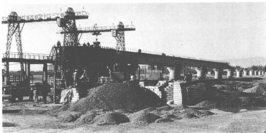
宝中铁路中卫黄河桥顶推法施工
