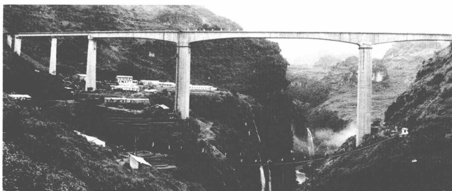
南昆铁路清水河大桥(1998 年)
