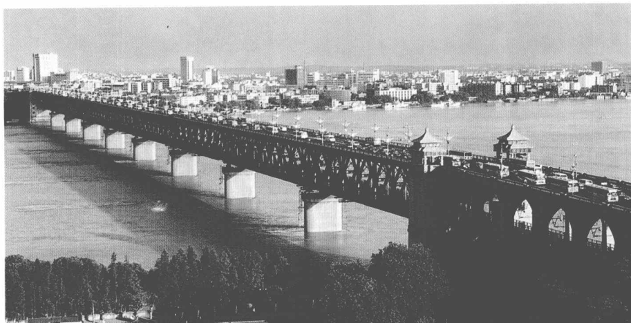
万里长江第一桥——武汉长江大桥(公铁两用,1957年)
