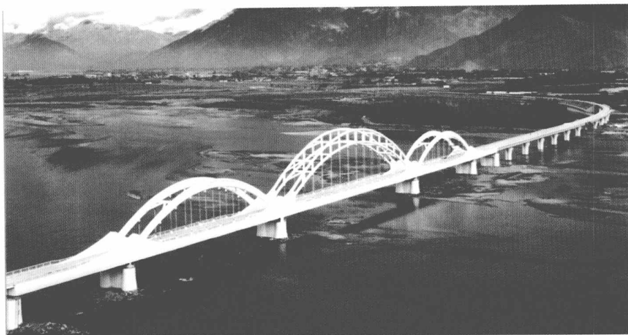
青藏铁路拉萨河大桥(2005 年)
