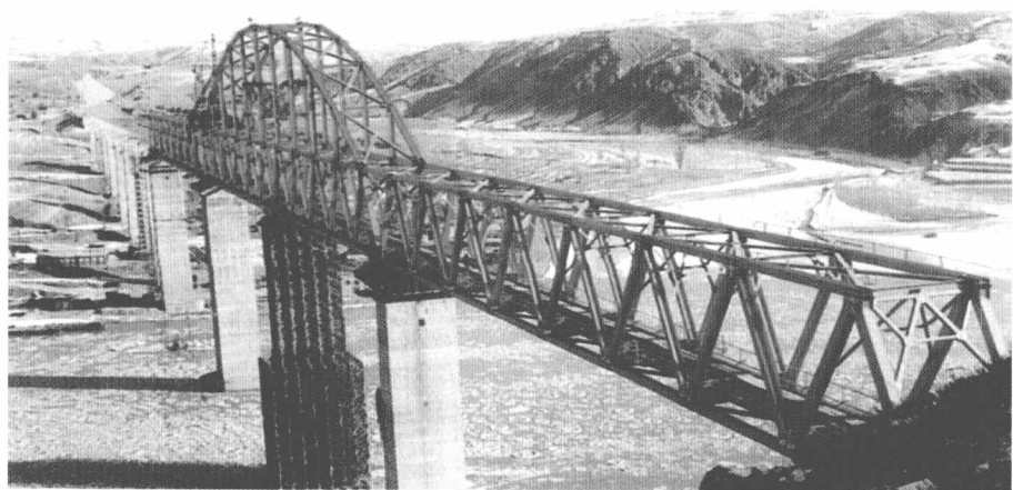
大准铁路黄河桥无竖杆三角形连续刚性桁梁柔性拱钢桥施工
