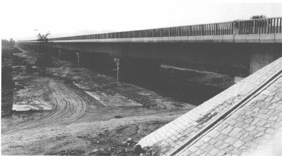
秦沈客运专线小清河大桥(2001 年)
