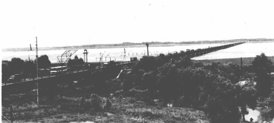
京汉铁路郑州黄河老桥(1905 年)
