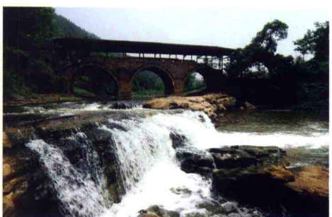
▲ 中国名桥——忠县两河廊桥
