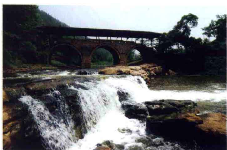
▲ 中国名桥——忠县两河廊桥
