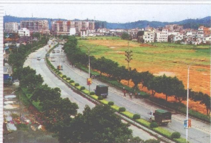
■ 杜阮镇江杜一级公路(2002年)
