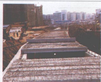
■ 江会公路二期扩宽工程施工情况
