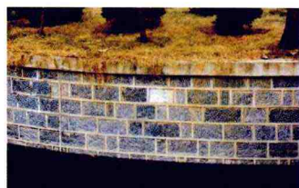
7 规则式错缝的浆砌块石护岸
