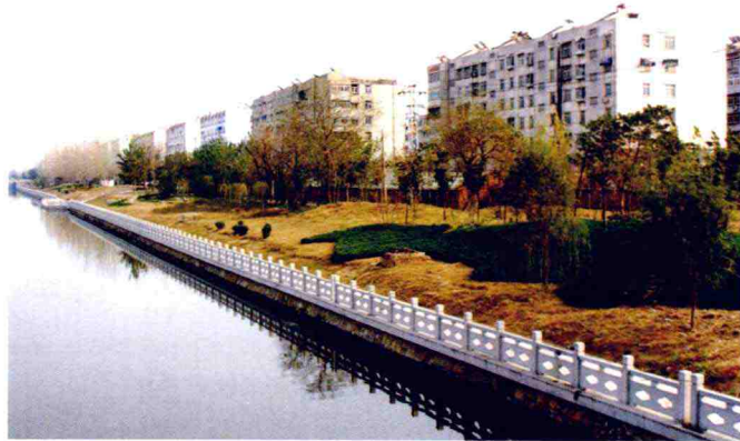
5 与图4断面形式对应的垂直式护岸实例
