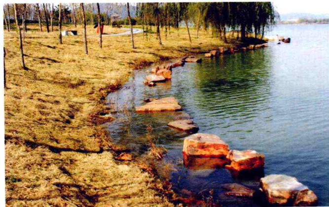
13 植被护坡与砌石护底相结合的湖堤护岸,在水边形成丰富的土石空腔,成为水生动物产卵、繁衍的巢穴。由于砌石基本没于常水位线下,极大地减弱了硬质材料的影响
