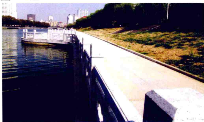
18 与图 15 对应、间隔布置有休息亲水平台的复合式护岸
