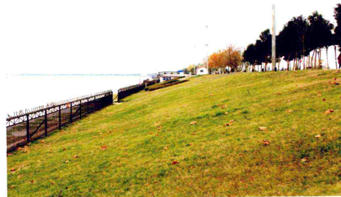
11 坡度适中的坝堤斜坡护岸
