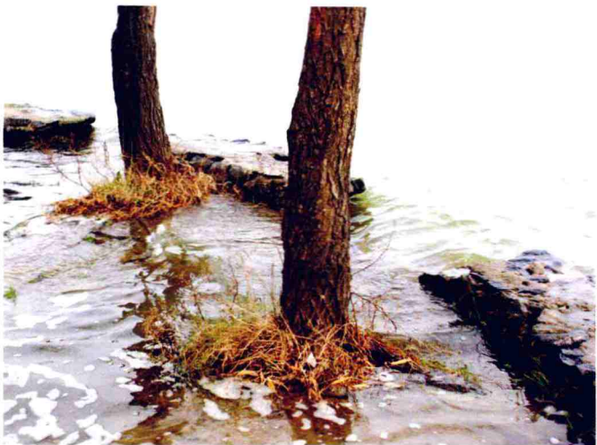
11 护岸的高度和宽度禁不住暴涨湖水和风浪的冲刷
