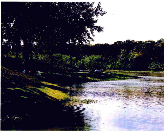
1 这是采用草皮、灌木和乔木组成的层叠复合式的生态护岸
