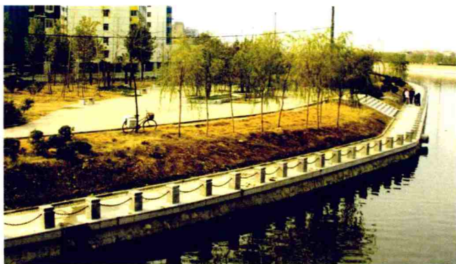
17 与图 14 对应、带亲水步道的复合式护岸
