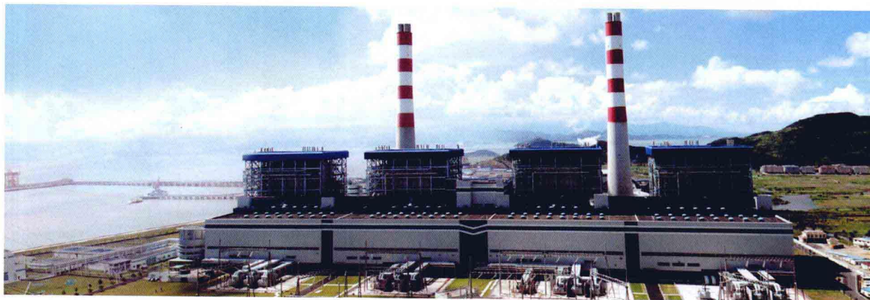
▲ 省重点工程——华能玉环电厂
