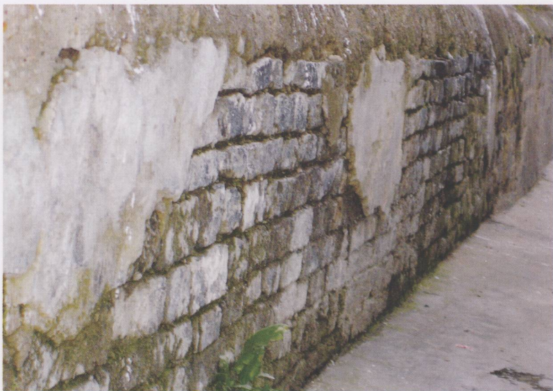
扬州两淮盐漕察院东围墙墙基
