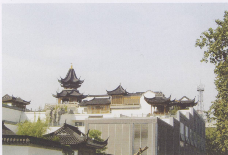
正在建设中的江宁织造府博物馆
