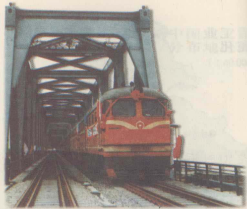
火车通过黄河京九铁路大桥
