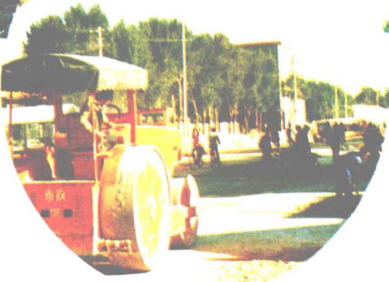
市政建设工地
