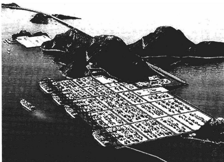
图 1.1 上海国际航运中心洋山深水港工程
