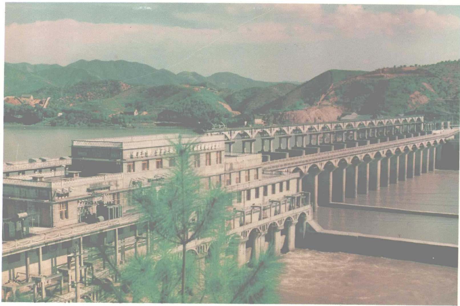
甘溪水轮泵水电站
