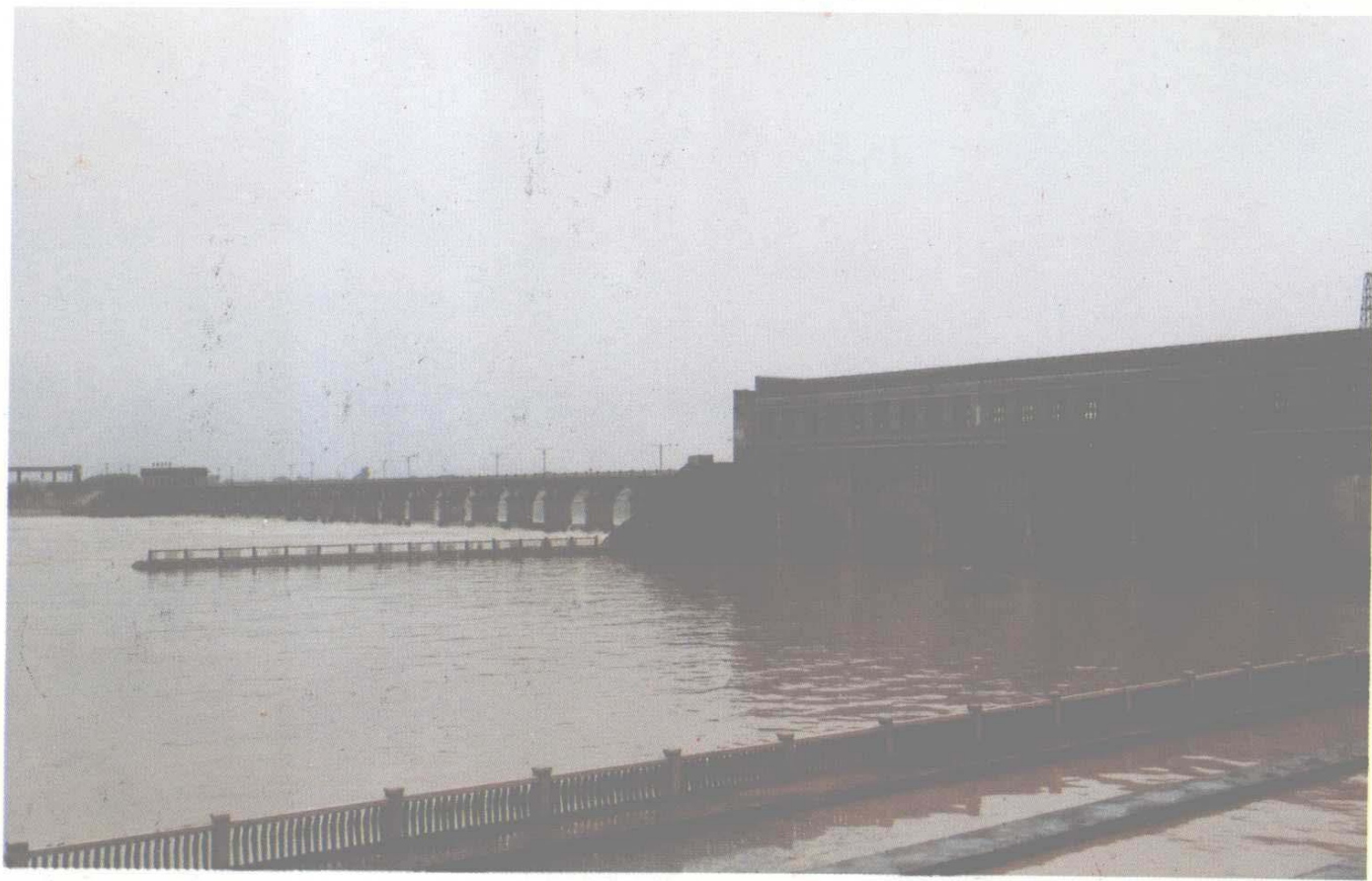
洋塘水轮泵水电站
