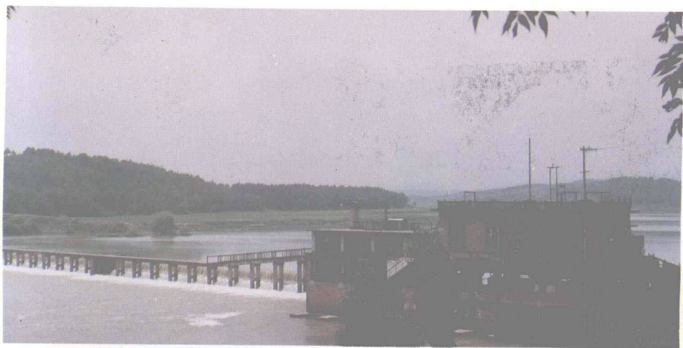
望日岩水轮泵水电站
