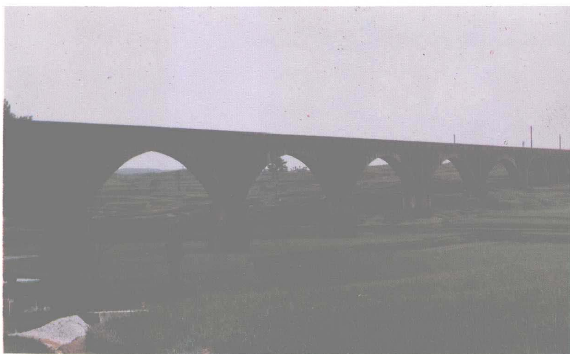
望日岩石拱渡槽
