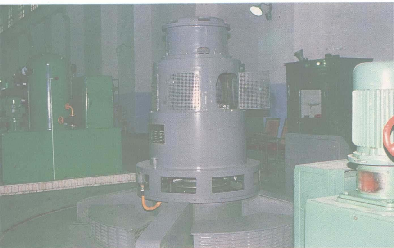
甘溪电机厂生产的1250千瓦发电机
