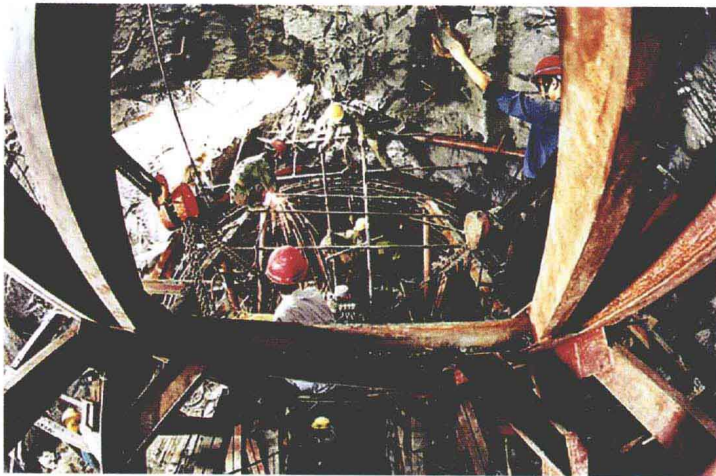
长江三峡水利枢纽工程永久船闸输水隧洞斜井变径滑模安装
