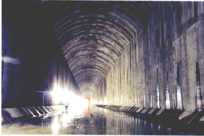
四川锦屏水电站右岸导流洞
