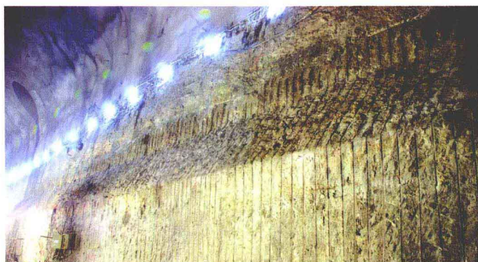
金沙江溪洛渡电站右岸地下厂房岩锚梁岩台开挖
