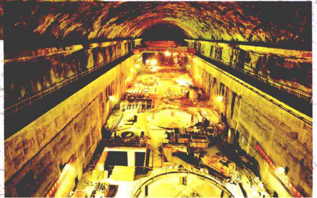
施工中的广东惠州抽水蓄能 电站地下厂房
