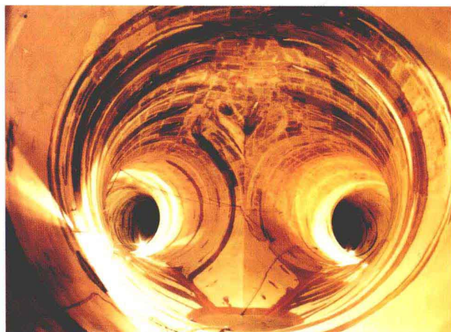
云南大朝山水电站尾水隧洞岔管
