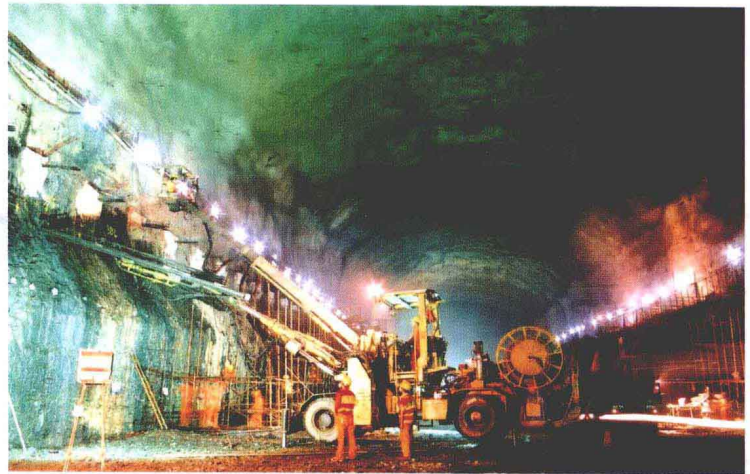
开挖中的金沙江溪洛渡水电站地下厂房
