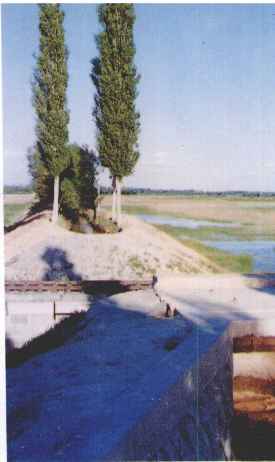
王田抗旱渠穿包兰铁路倒虹工程
