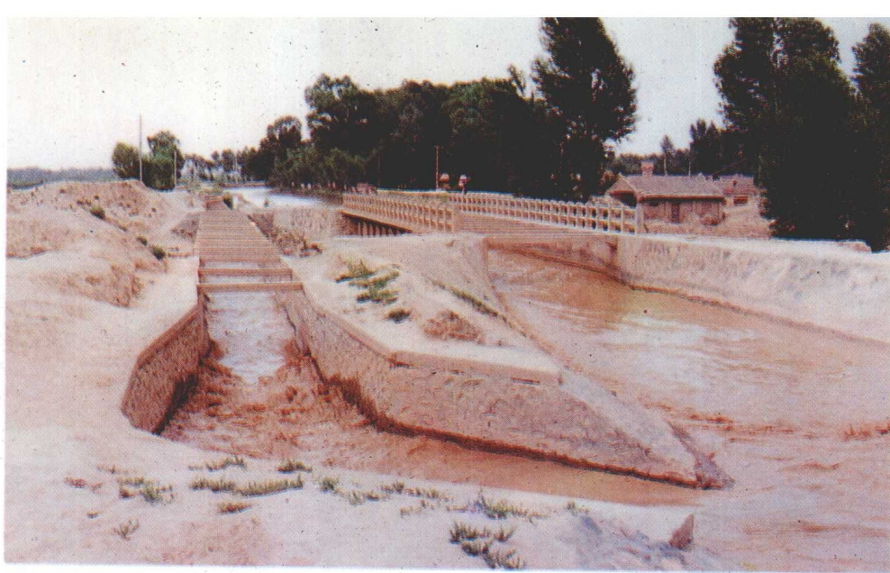
汉延渠第二排水沟双渡槽
