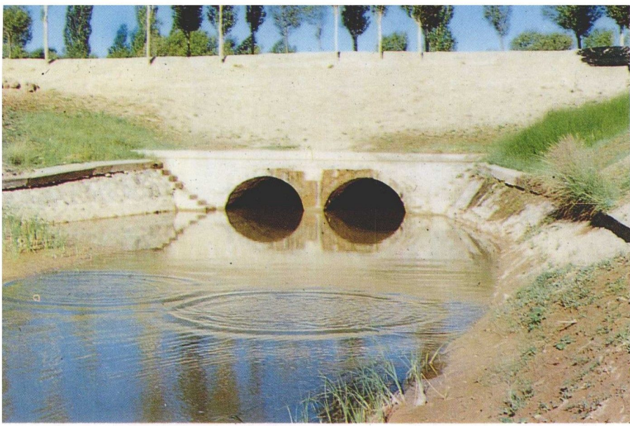
丰庆沟穿唐徕渠涵洞
