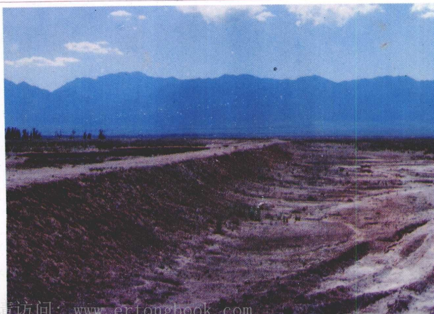
金山防洪堤一瞥
