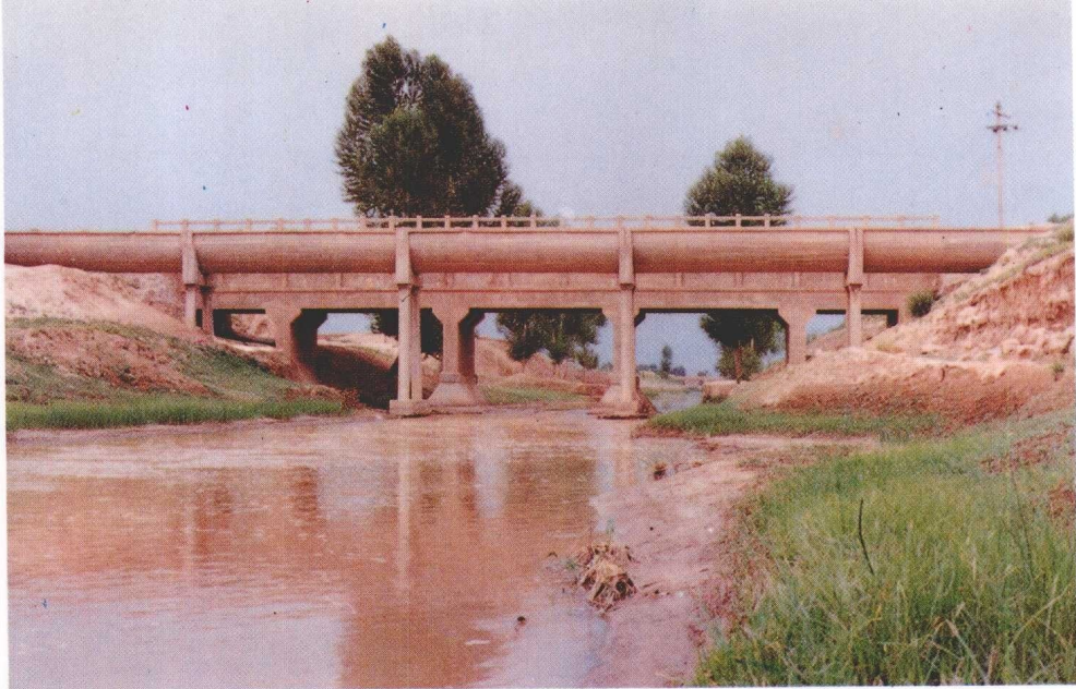
汉延渠二排渡槽
