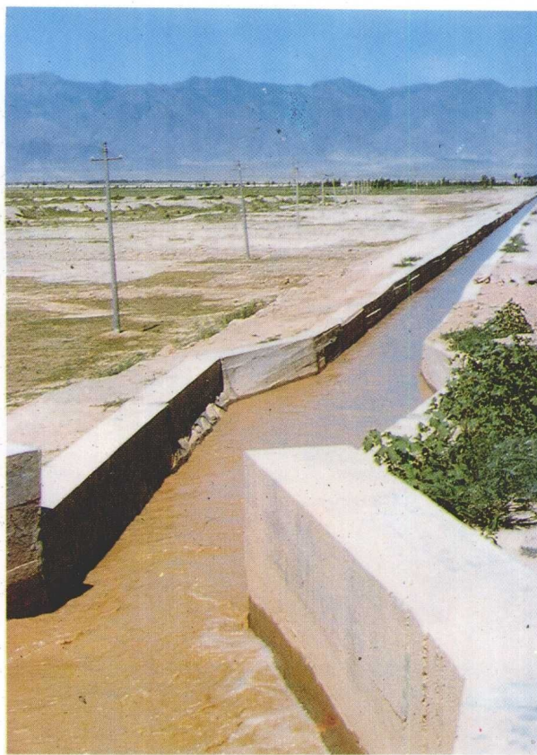
金山乡一号扬水渠砼U型砌护渠
