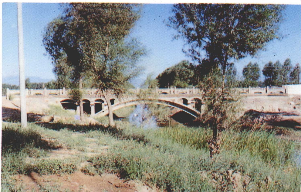
丰庆沟包兰公路双曲拱桥
